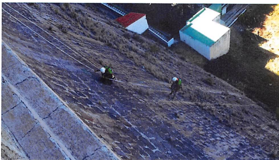
Figura 16. Imagen de los trabajos verticales empleados en la realización de los ensayos de Tomografía Sísmica Cross-Hole, en el paramento de aguas abajo.
