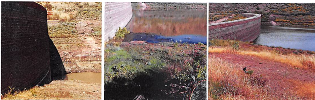
Figura 3. Derecha. Vista del nivel de agua de la presa en febrero (visita) mucho más bajo que durante la realización de los trabajos de geofísica de superficie en marzo (centro) y el nivel, algo superior que éste último, en el mes de mayo, durante la ejecución de la geofísica en pozo (izquierda).
